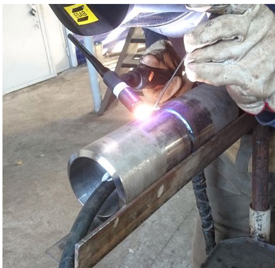
Рисунок 5 – Заполнение полости трубопровода аргоном для защиты корня шва от окисления.
