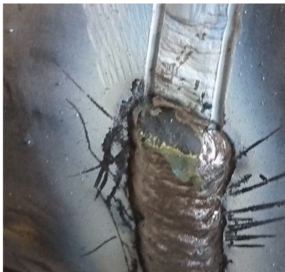
Рисунок 5 – Выполнение РД облицовочного шва Ду 200 (положение В1)
