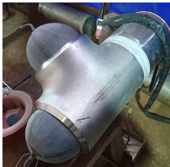
Рисунок 6 – Заполнение полости трубопровода аргоном для защиты корня шва от окисления.
