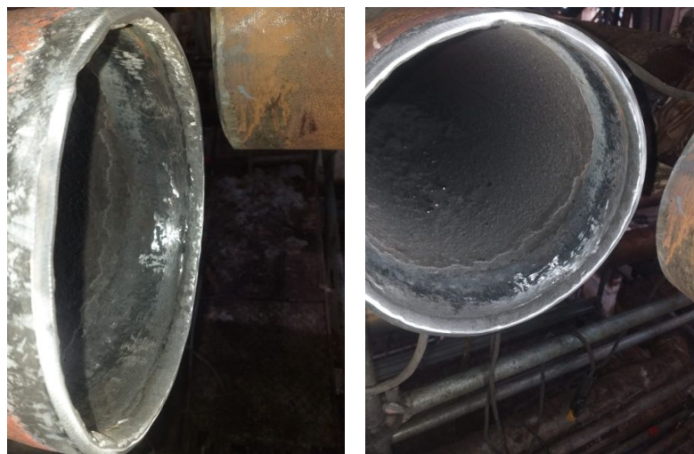
Рисунок 5 – Фотографии выполненной наплавки внутренней поверхности трубы, находившейся в эксплуатации
